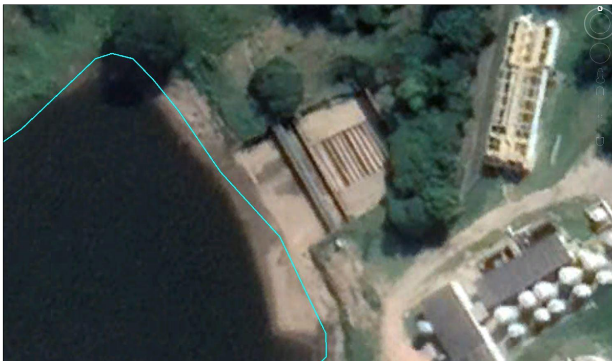
Figura 2.3 – Vista Aérea da Área da Barragem - Detalhe. Fonte: Google Earth, Data das Imagens: 05/01/2021.
