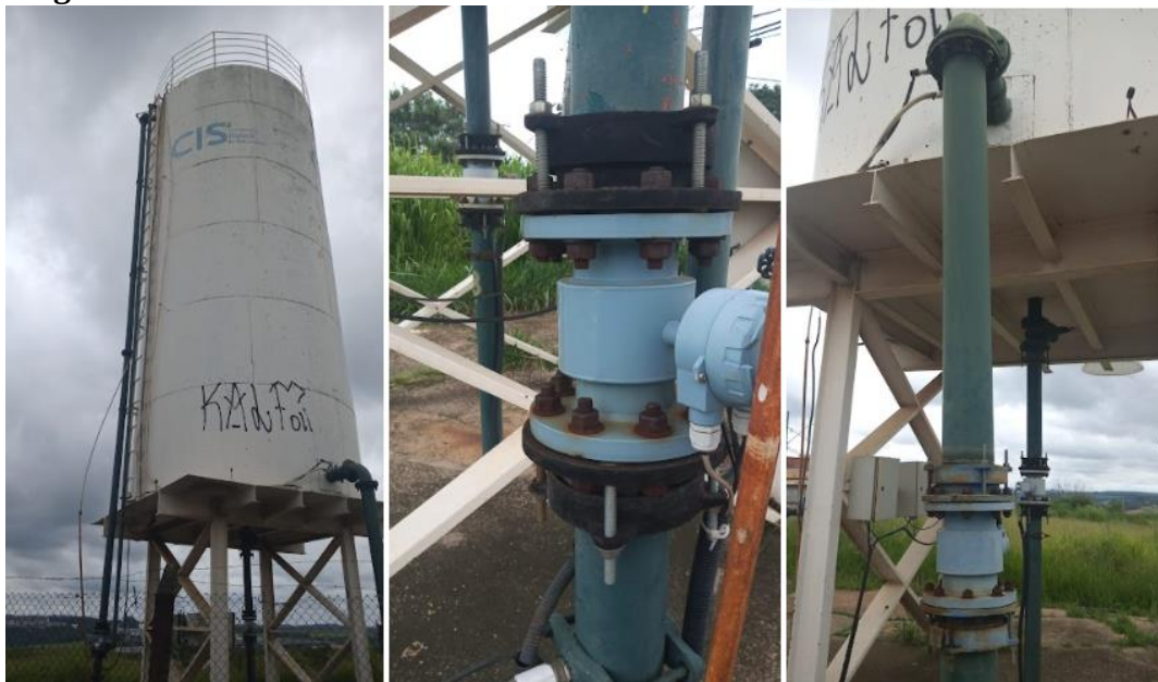
Figura 1- Estruturas metálicas localizadas no Bom viver
