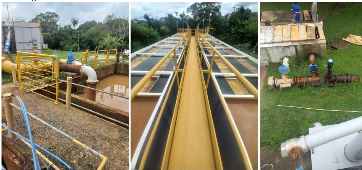
Figura 4- Estruturas metálicas localizadas na ETAVII- Itaim
