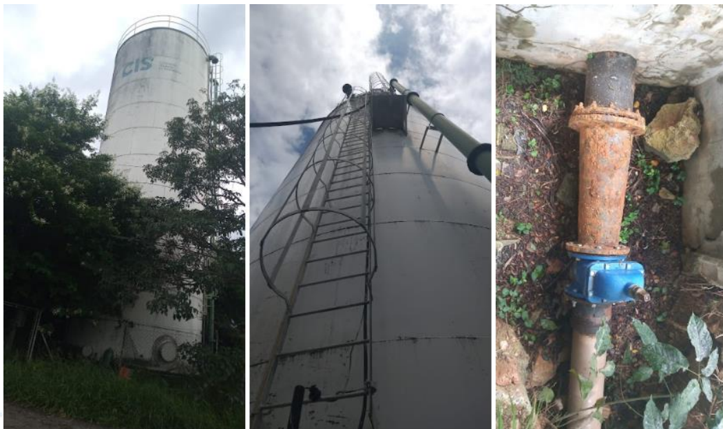
Figura 2- Estruturas metálicas localizadas no Campos de Santo Antônio
