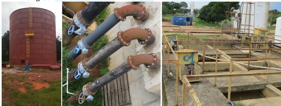
Figura 5- Estruturas metálicas localizadas na ETAVIII
