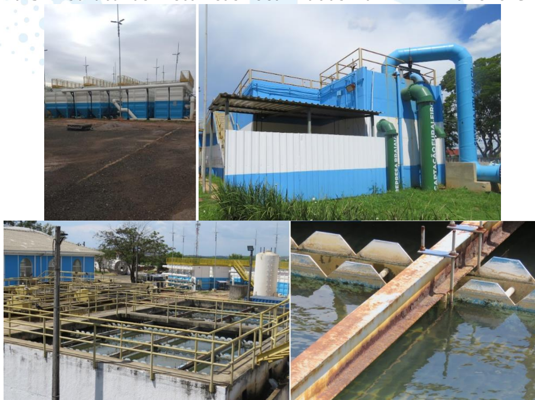
Figura 3- Estruturas metálicas localizadas na ETAI- Rancho Grande
